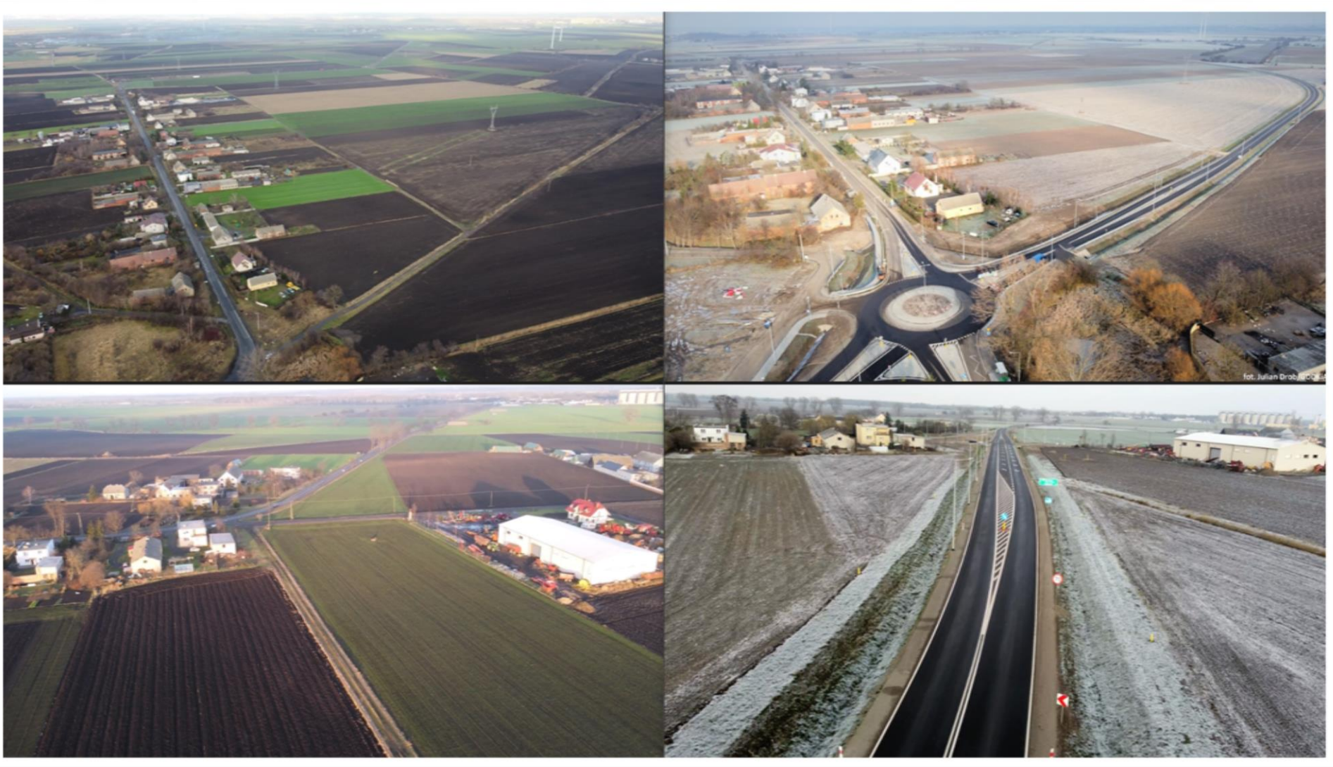
Przed i po - Rozbudowa DK62 Strzelno – Kobylniki (koniec 20 XII 2023)
