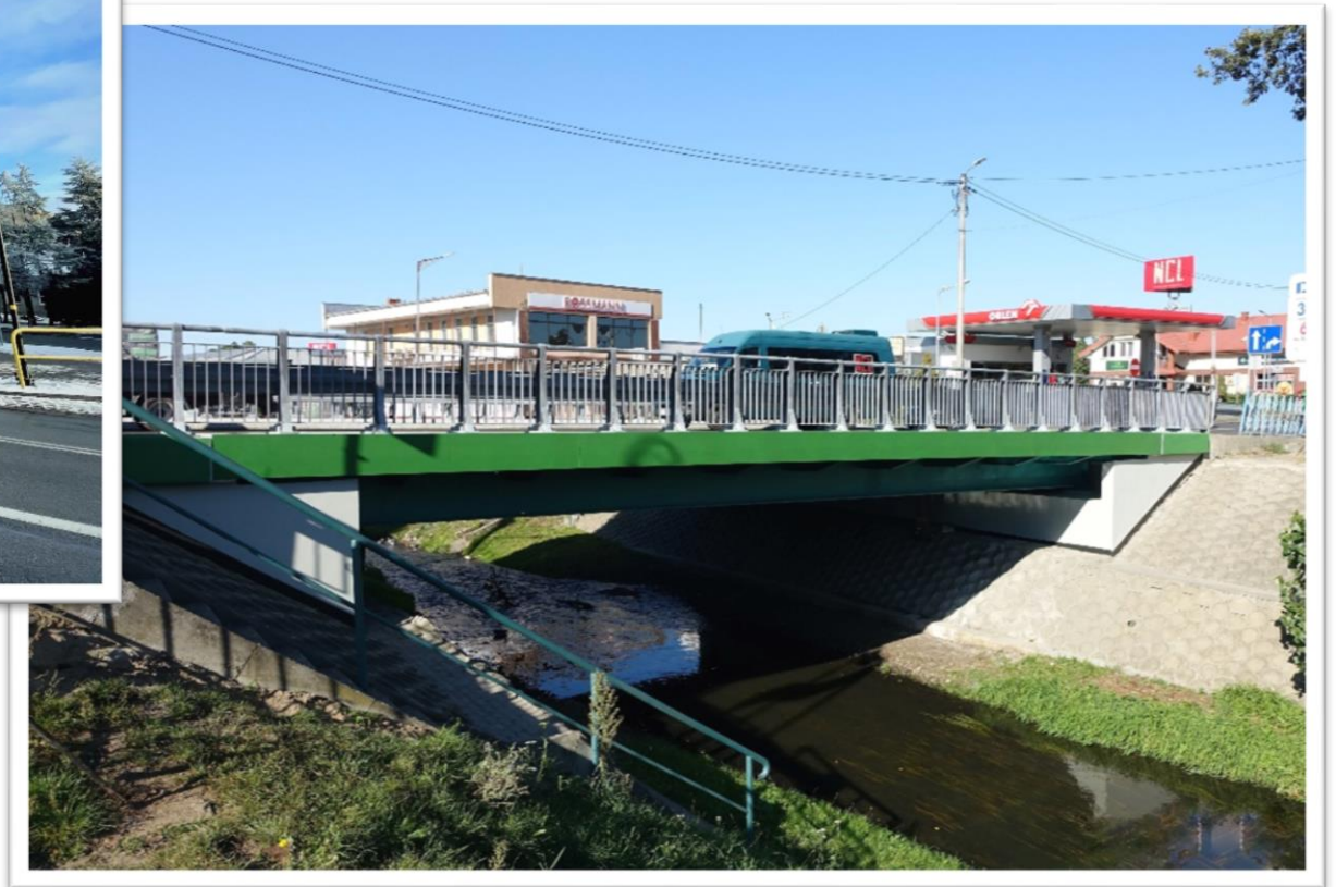
Koniec remontu mostu na DK67 w Lipnie
